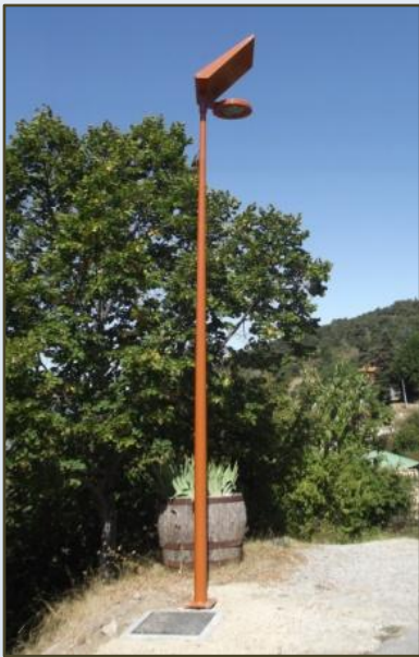
coffre batteries dans regard hydraulique
